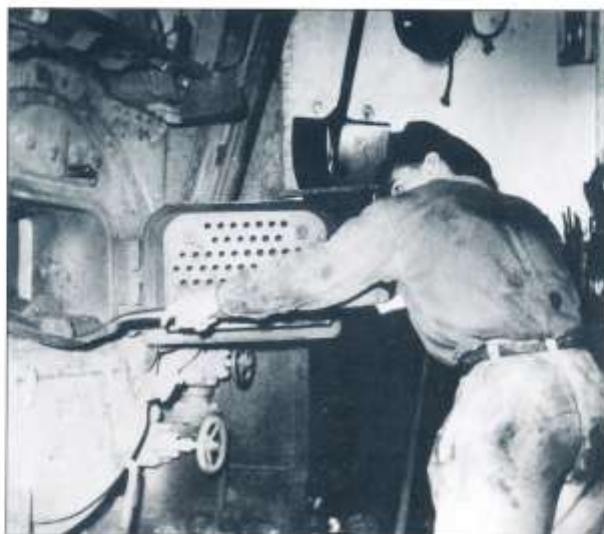
Varmaste jobbet ombord hade eldarna. Bravida förbrukade 300 kg stenkol i timmen. Folke Havik praktiserade ombord sommare 1950. Enligt egen utsaga var det "slitsamt, sotigt, fett och djävligt". Foto från Folke Havik
